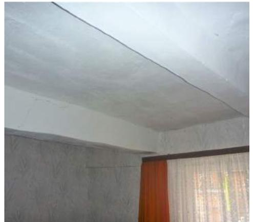
Später wurden sie durch Lehmschlag auf Einschubbrettern und durchgehende Unterdecken aus Brettschalung mit Kalkputz auf Schilfrohr ersetzt (sog. Rohrputzdecken).
