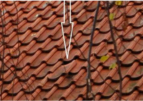
Dieser verrutschte Dachziegel führte zu dem unten abgebildeten Schaden.
