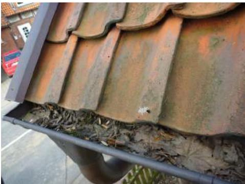
Laub oder anderer Dreck sollte regelmäßig entfernt werden, um Verstopfungen zu vermeiden. Schäden durch Korrosion oder aufgeplatzte Lötstellen müssen zeitnah durch einen Dachdecker beseitigt werden. Dieser kann auch helfen, wenn das Entwässerungssystem für die Größe der Dachfläche nicht ausreichend dimensioniert ist.
