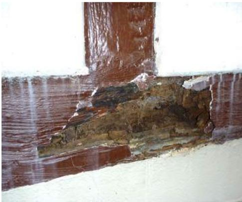
Diese verlangen u.a., dass Außenwände wasserdicht sein müssen. Das schien bei Fachwerkwänden nur mit Produkten der Chemieindustrie zu gelingen, und so wurden (und werden teilweise immer noch) munter die vielen Anschlussfugen, Holzrisse und Holz nagellöcher mit dauerelastischen Dichtstoffen oder Epoxidharz geschlossen und anschließend oft noch mit dichten Anstrichen (sog. „Elefantenhaut“) überzogen.
